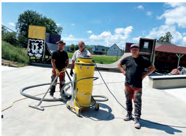
Arbeiter beim Feinschliff im Skaterpark
