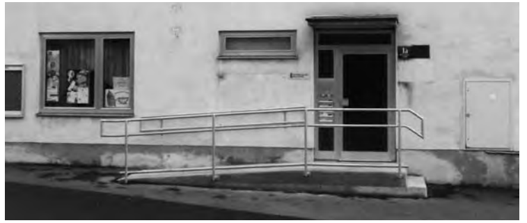
Abbildung 3 – Der Eingang zur Bibliothek nach der Umgestaltung
